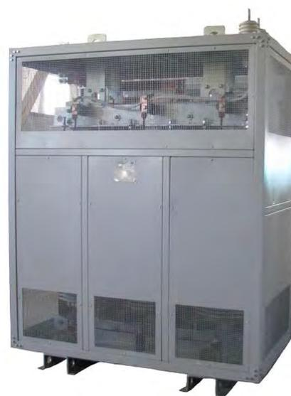
Трансформатор ТС3 630 кВА в кожухе IP21
